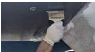
Overstryk High Protect i modsat retning med pensel
