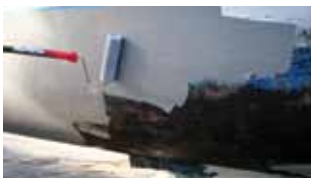
Påfør Underwater Primer på overfladen
