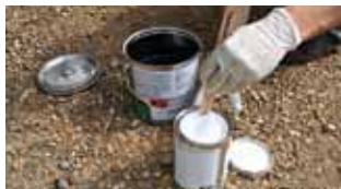
Rør i hærderen
