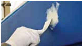
Udfyld ujævnheder med spartel
